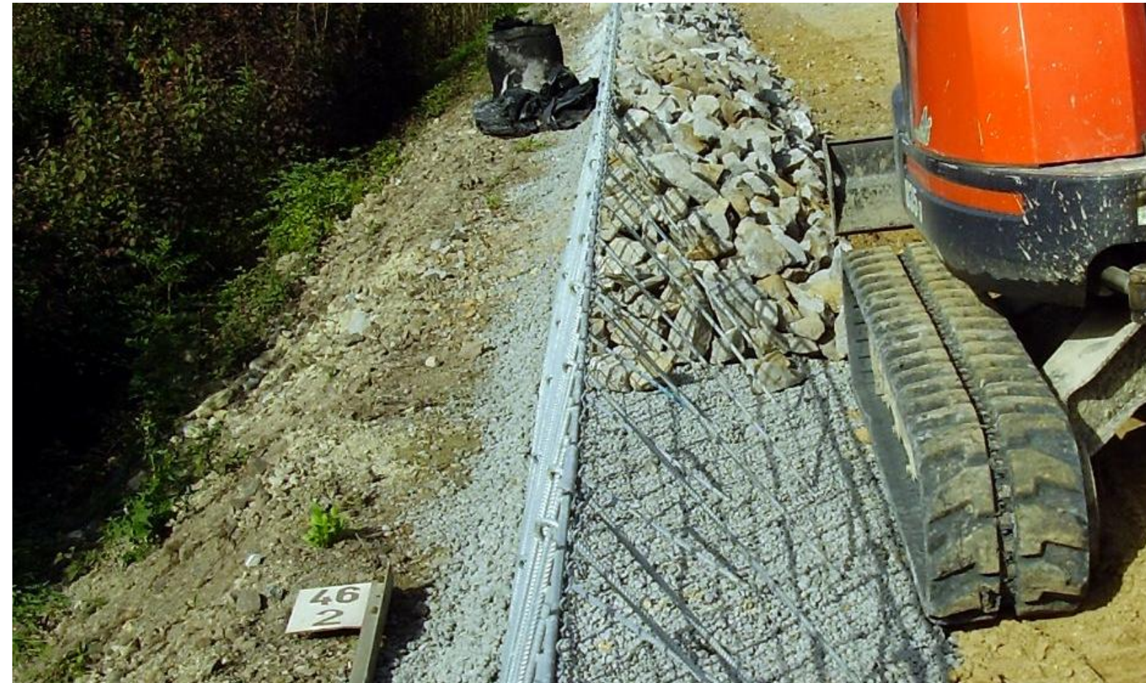
Construction de Rügeli
