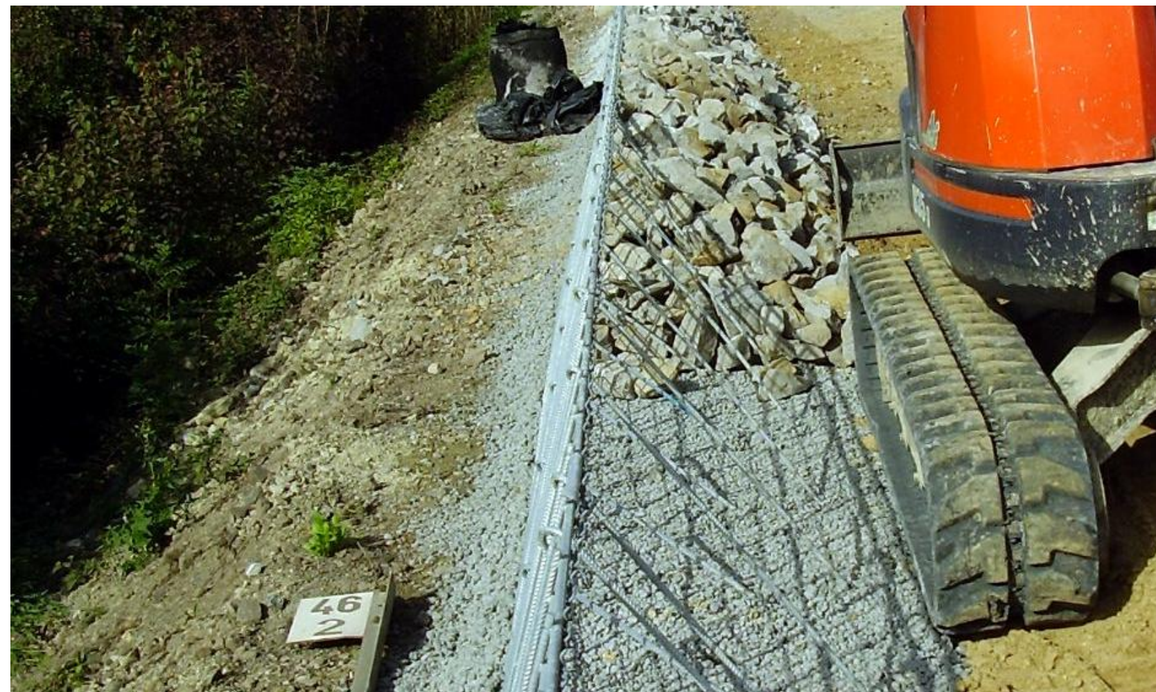
Construction de Rügleri
