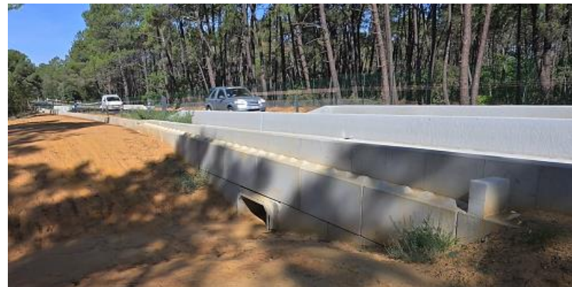
Passage à petite faune (CEREMA)
