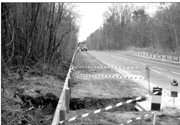
Figure 2 : Détail d'un des "crapauducs" en cours de réalisation sur la RD104 à proximité de Sorques (77).
